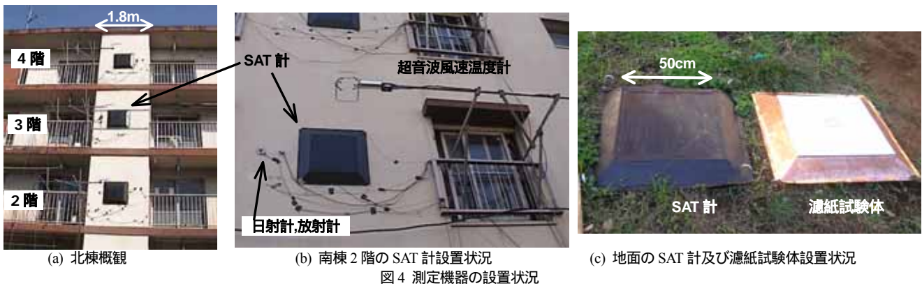
図4 測定機器の設置状況
